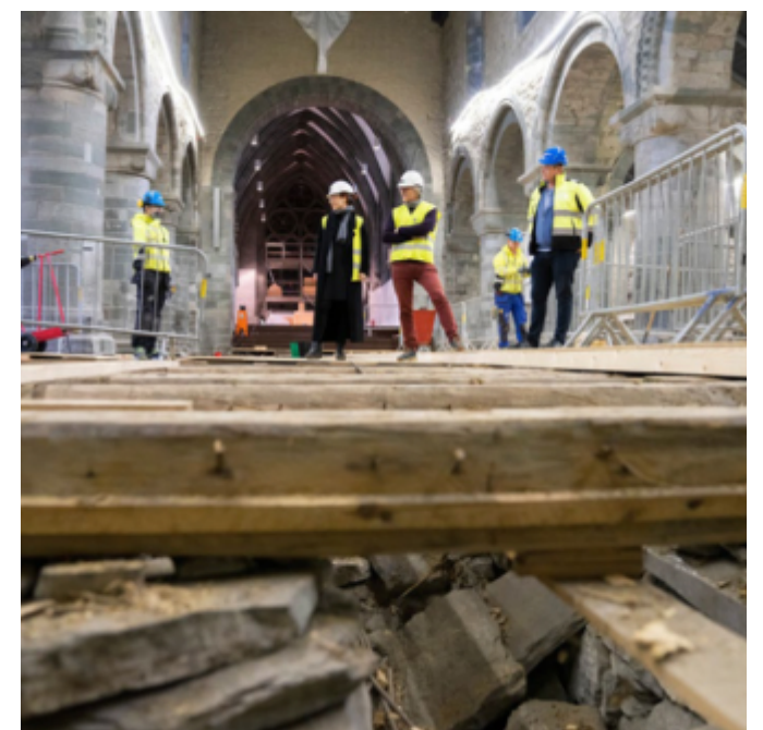
Det blir graving i tre av kammerne under Stavanger Domkirke. JON INGEMUNDSEN
